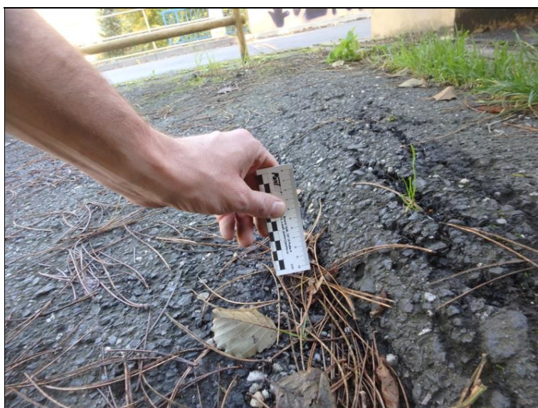
Deformace chodníku na pravé straně před opěrou OP1.
