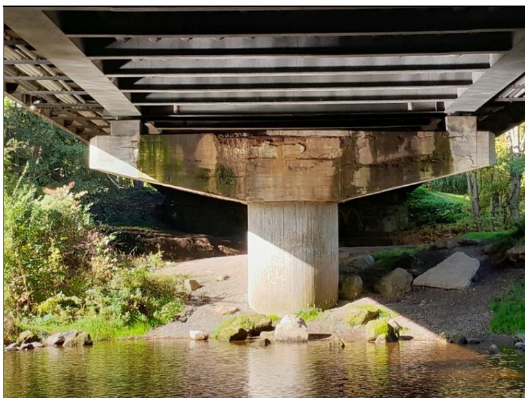
Pilíř P2, silné zatékání.
