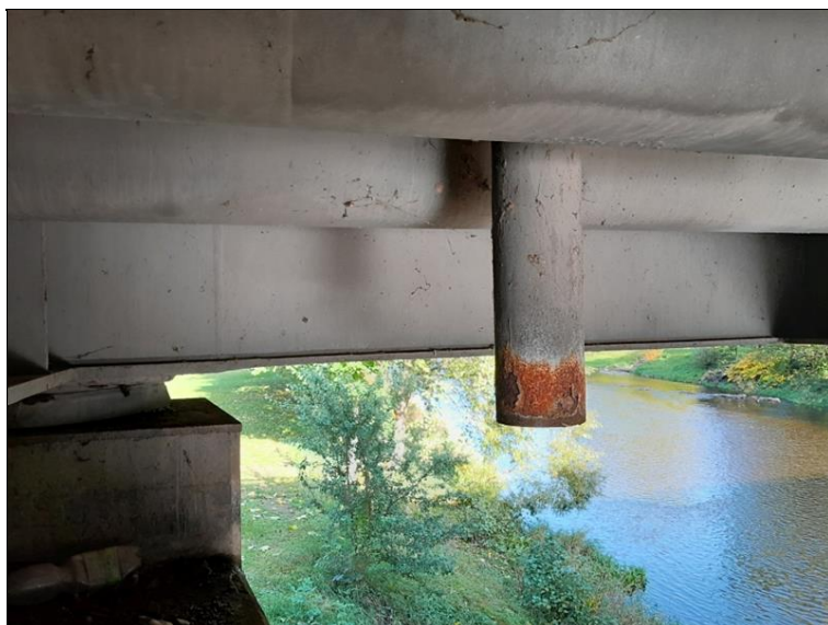
Koroze konce odvodňovacího svodu u pilíře P2.
