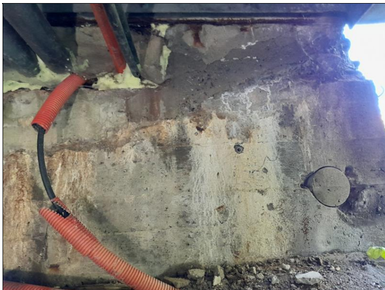
Silné průsaky na levé straně závěrné zdi opěry, poškozená chránička inženýrské sítě.
