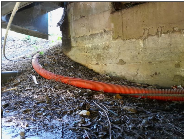
Množství nečistot na úložném prahu opěry OP1.
