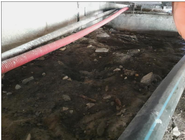
Nános nečistot na úložném prahu opěry OP3.
