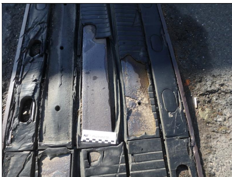
Detail poškozeného mostního závěru nad pilířem P2.
