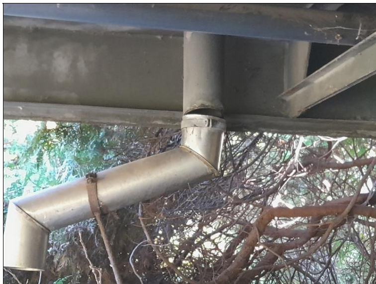
Rozpojený svod odvodnění u opěry OP3.
