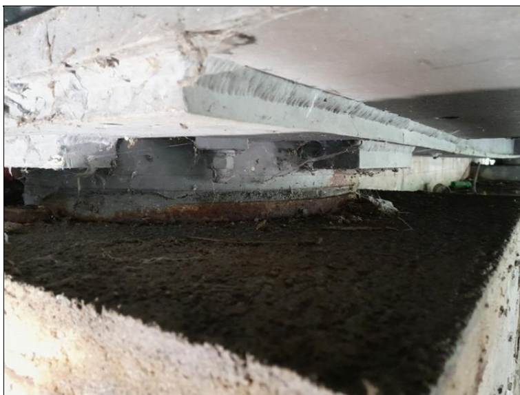
Pravé ložisko na opěře OP1, plošná koroze spodního hrnce ložiska.
