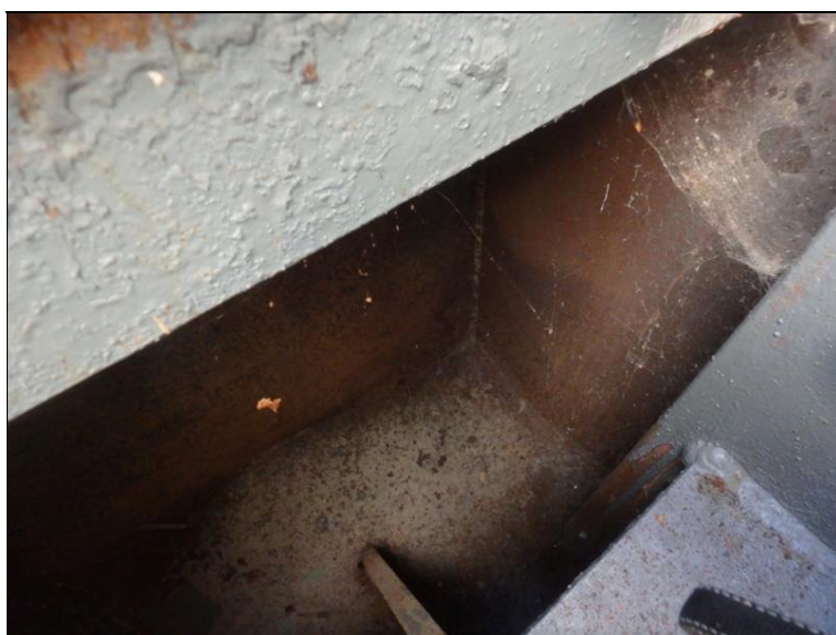
Koroze ocelové konstrukce uvnitř komorového parapetního nosníku, pole 2, pravý nosník.
