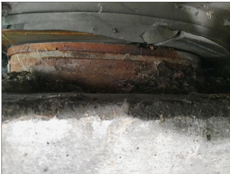
Pravé ložisko na pilíři P2, plošná povrchová koroze.
