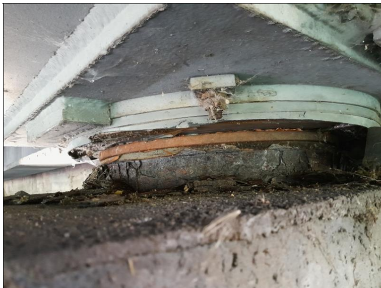
Pravé ložisko na opěře OP1, velmi silná koroze hrnce ložiska.
