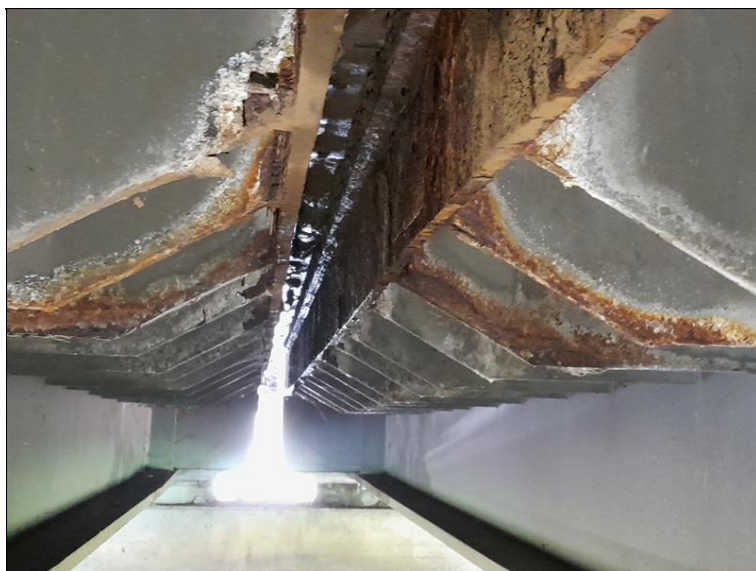
Silnější povrchová koroze na spodním lici nosné konstrukce pod mostním závěrem nad pilířem P2.
