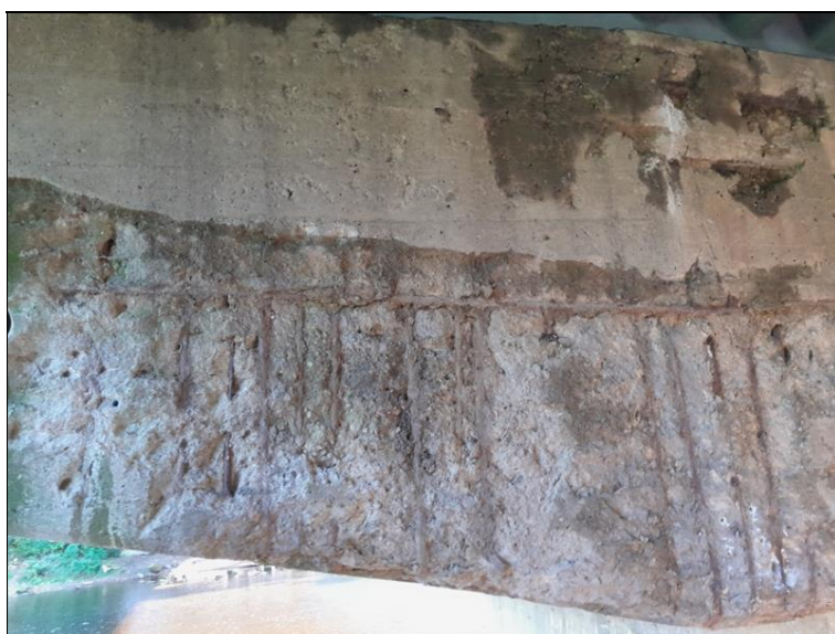
Pilíř P2, pohled do pole 1, plošná koroze betonářské výztuže.
