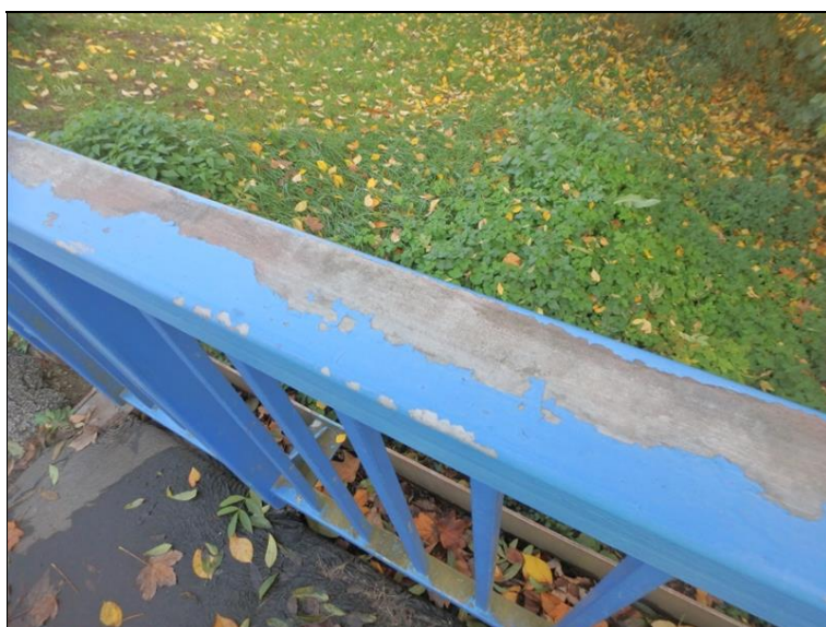
Plošně poškozená protikorozní ochrana horního madla.
