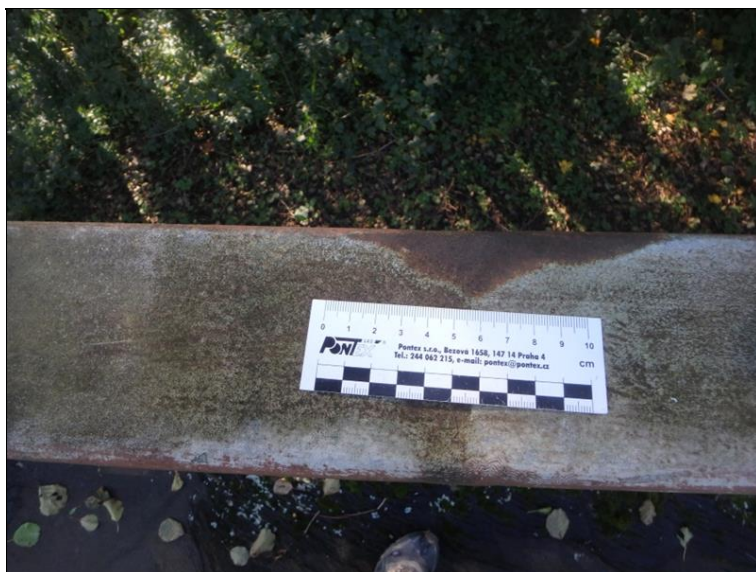
Povrchová koroze zábradlí.
