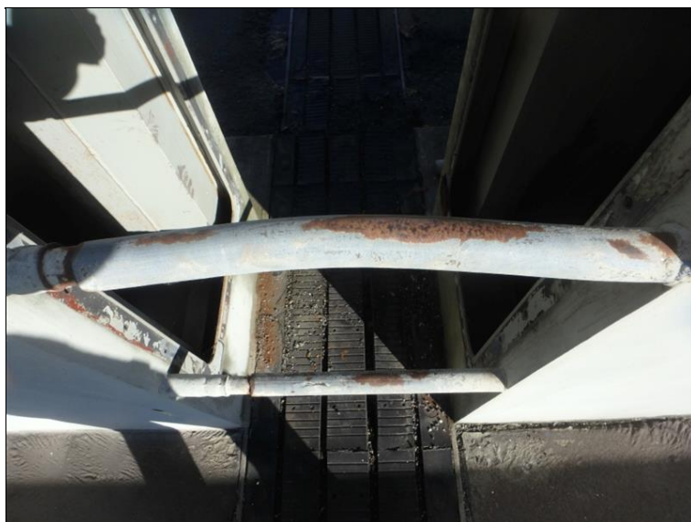
Deformované zábradlí nad pilířem P2, povrchová koroze.
