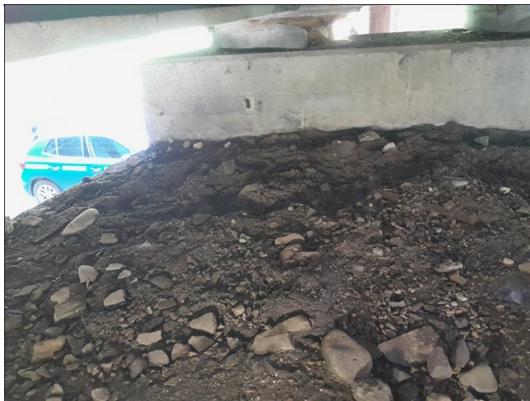
Nánosy nečistot na horním líci úložného prahu pilíře P2.
