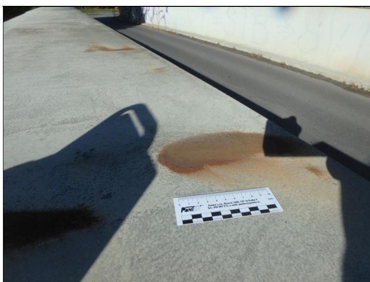
Lokální povrchová koroze na horním líci pravého ocelového parapetního nosníku, pole 1, pravá strana.
