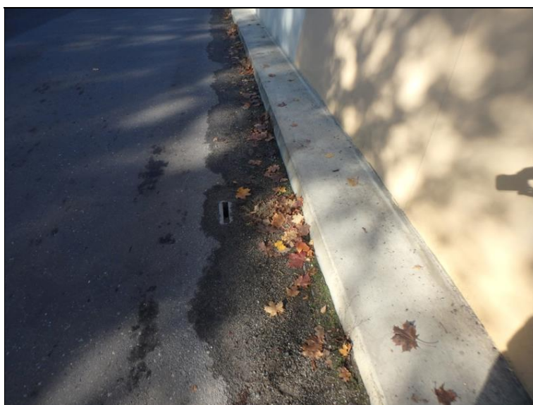
Množství nečistot u kraje vozovky, zanesený odvodňovač ve vozovce.
