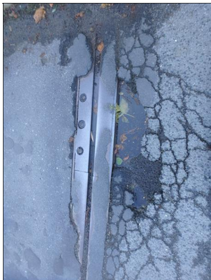
Detail poškozené vozovky u mostního závěru nad opěrou OP1.
