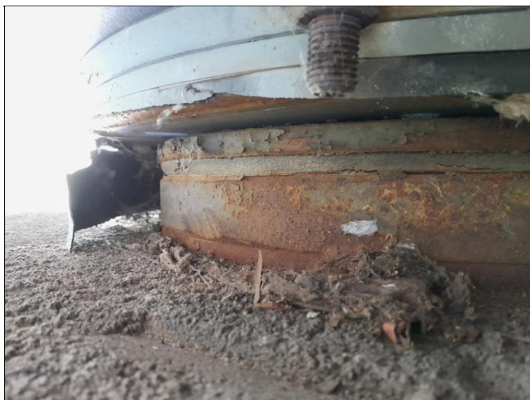
Plošná povrchová koroze pravého ložiska na pilíři P2.
